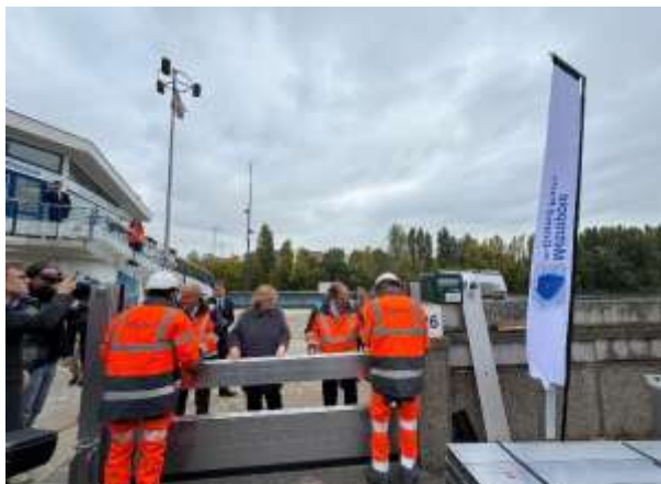
Pose de batardeaux témoins à Courbevoie, Quai Paul Doumer (92)
